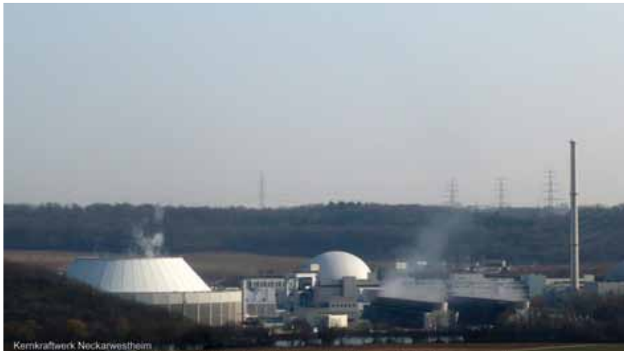
Behmel 15.02.13 Anlage 7: Das GKN auf Fels gebaut? Wesentliche Anlagen stehen auf wasserdurchlässigem Kalksteinschutt 6 m tief unter dem Neckarwasserspiegel. Den gefährlich unzuverlässigen Untergrund darunter bildet löchriger Gips. Wichtige Rohr- und Steuerungsleitungen zwischen Reaktor und Maschinenhaus sind nicht gegen Auftriebskräfte abgesichert, deshalb müssen dauernd riesige Mengen Wasser abgepumpt werden. Jeder Liter Wasser bringt aufgelösten Gips mit sich. Zu den mindestens 18.600 \text{ m}^3 schon vorhandenen Hohlräumen kommt jeden Tag unaufhaltsam ein zusätzlicher Kubikmeter dazu.
